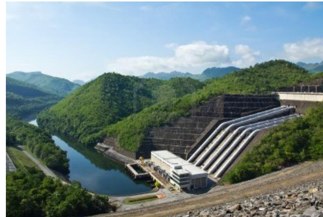
Impianti di media e grossa taglia
