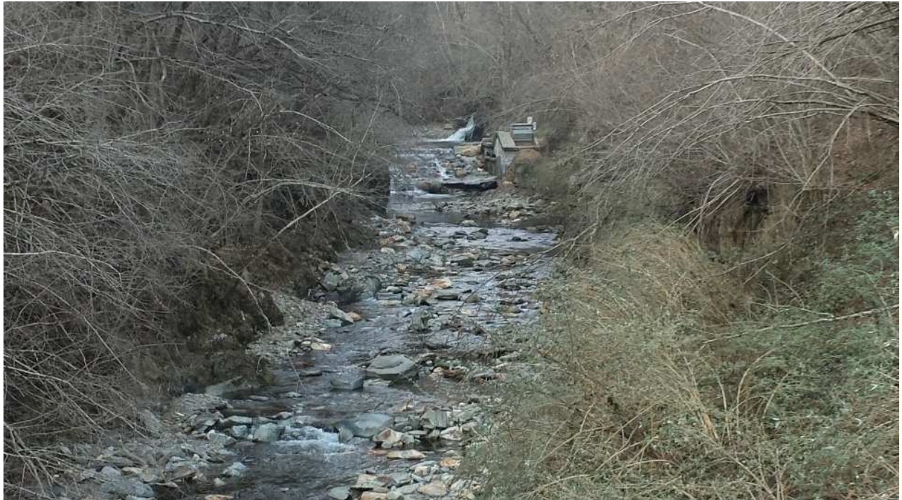
Figura 13. Sito di "Scareno". Ingrandimento della vista da valle dell'impianto. Foto scattata dal ponte della vecchia strada per Scareno nel mese di Febbraio, in assenza di vegetazione.
