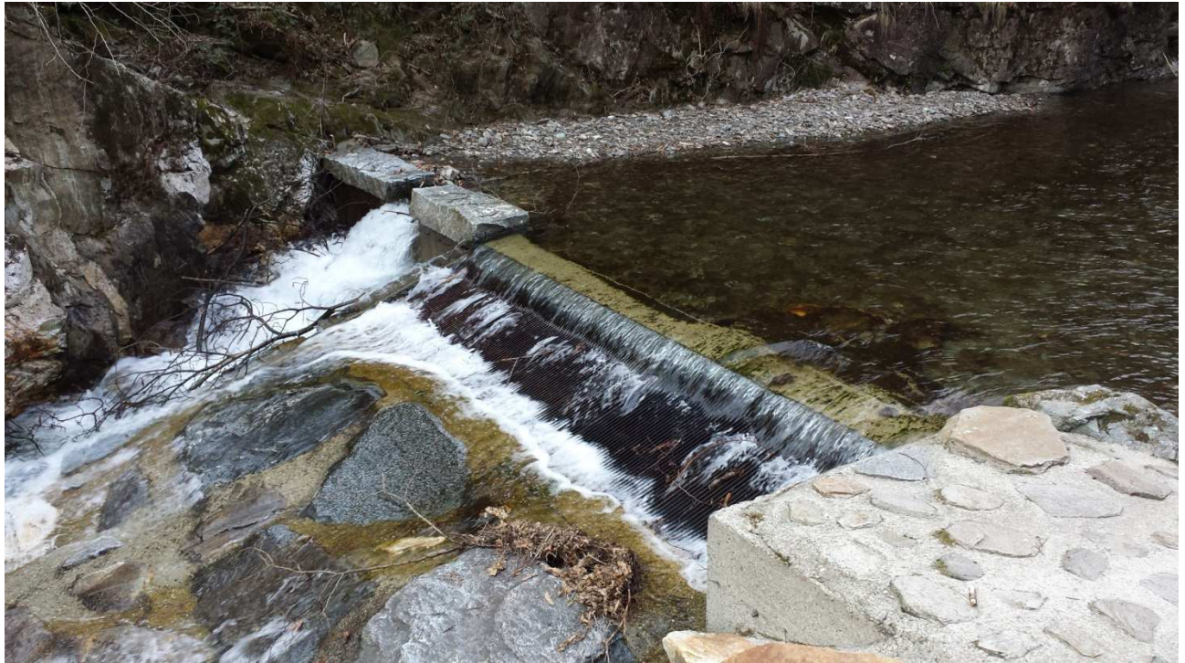
Figura 11. Sito di "Scareno". presa a trappola e scala di risalita dei pesci.
