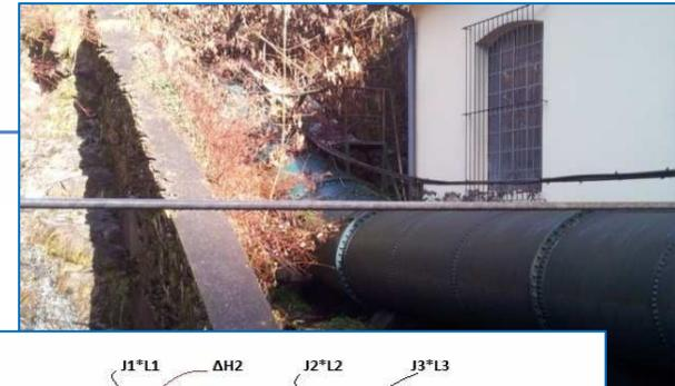
La quarta memoria prevede l'analisi di un impianto esistente. Viene ripercorsa la metodologia di calcolo che porta alla valutazione di dettaglio delle perdite di carico in un impianto, al fine di valutare gli eventuali effetti dovuti all'ammodernamento dell'impianto portano dei benefici alla produttività dell'impianto stesso. La memoria ripercorre quindi passo dopo passo l'analisi idraulica da effettuare per la valutazione del carico utile alla macchina.
